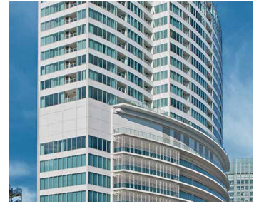
浜離宮インターシティ
