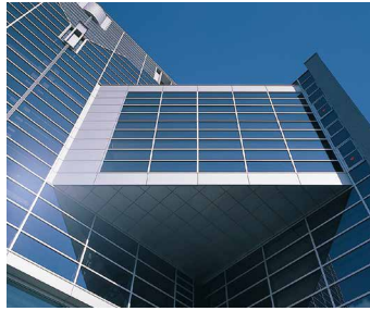
八尾市文化会館
